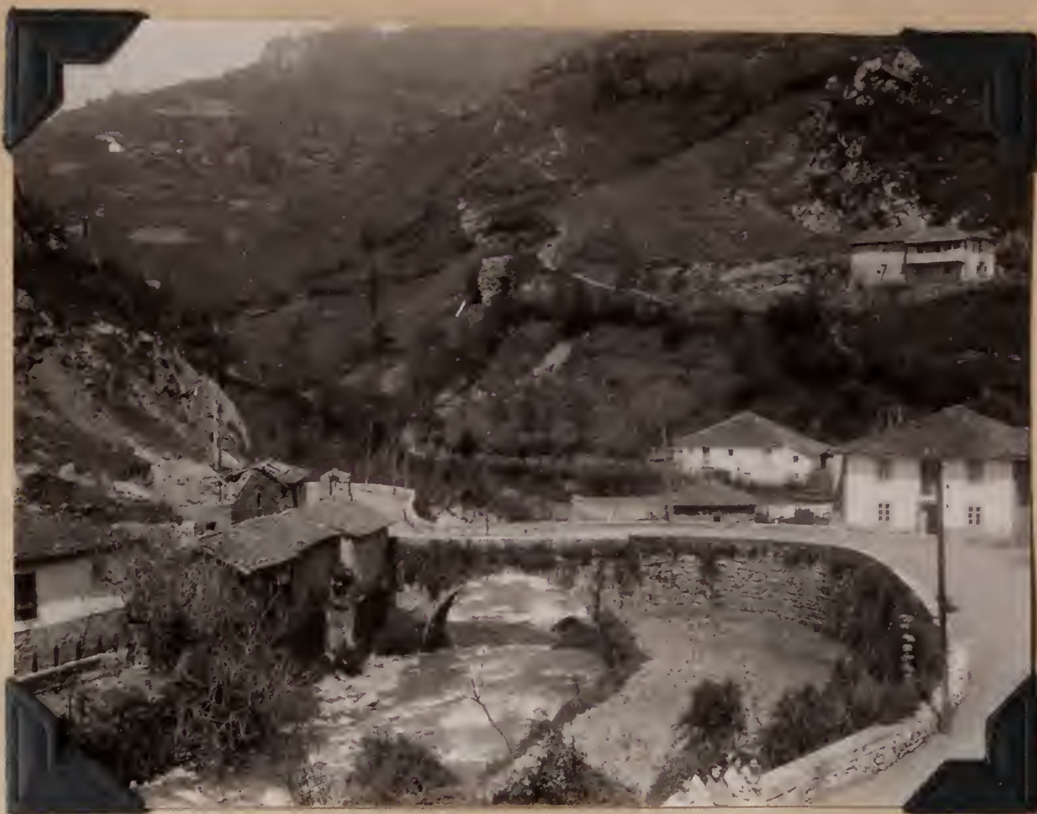
1962. View in Puente de los Fierros, Oviedo, Spain. May 4, 1930.
